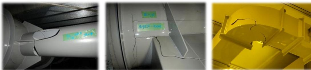
図 6. ダクト破損状況(ヒビ、割れ)
